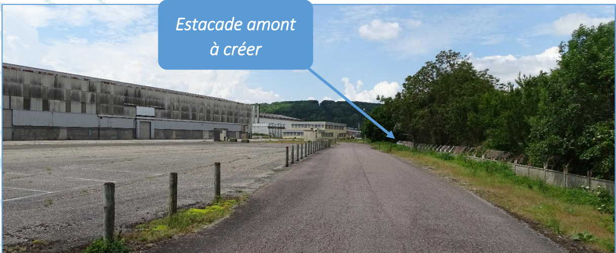
Fig. 17 : Vue n°5 : Voie de circulation Nord
