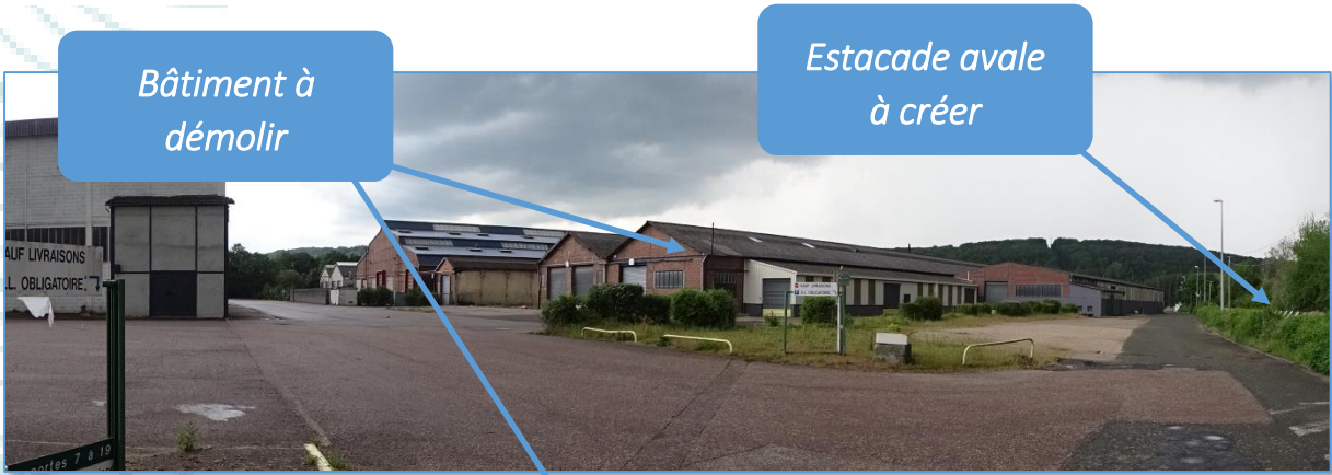
Fig. 15 : Vue n°3 : future plateforme containers
