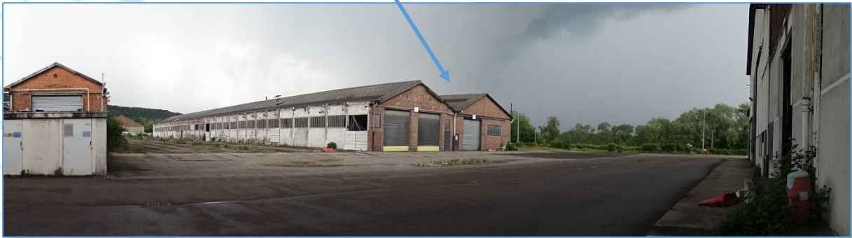
Fig. 16 : Vue n°4 : future plateforme containers
