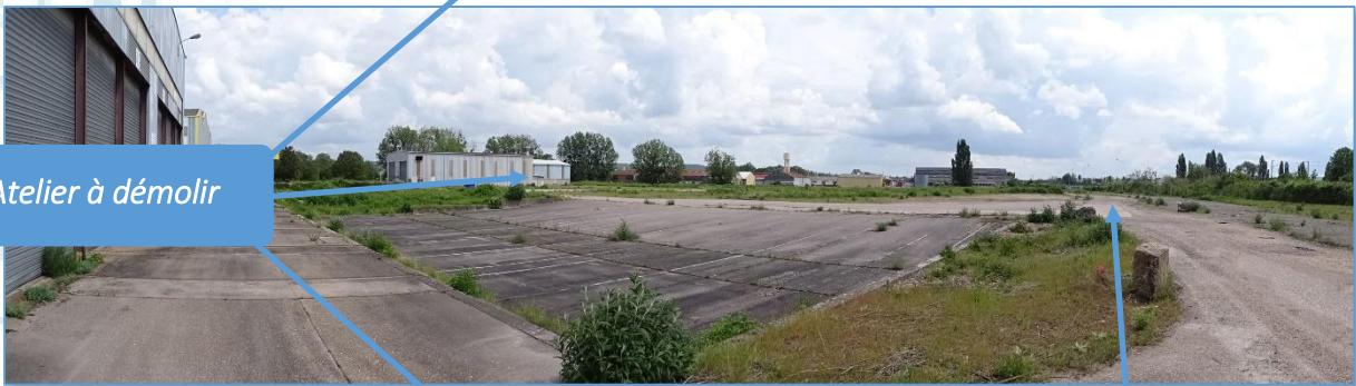
Fig. 19 : Vue n°7 : future plateforme granulats
