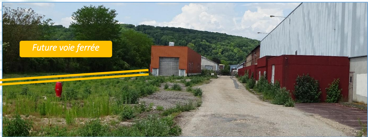
Fig. 21 : Vue n°9 : Espace Sud : future voie ferrée
