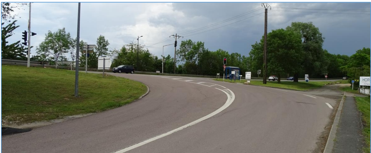
Fig. 2 : Débouché de la rue Jean de Beker Rémy sur la RD316.
