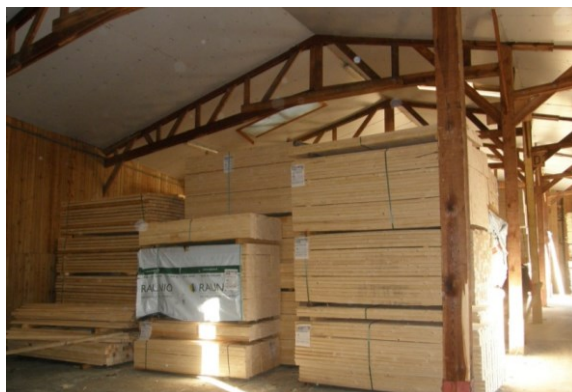
Photo 29 : Bâtiment de stockage
