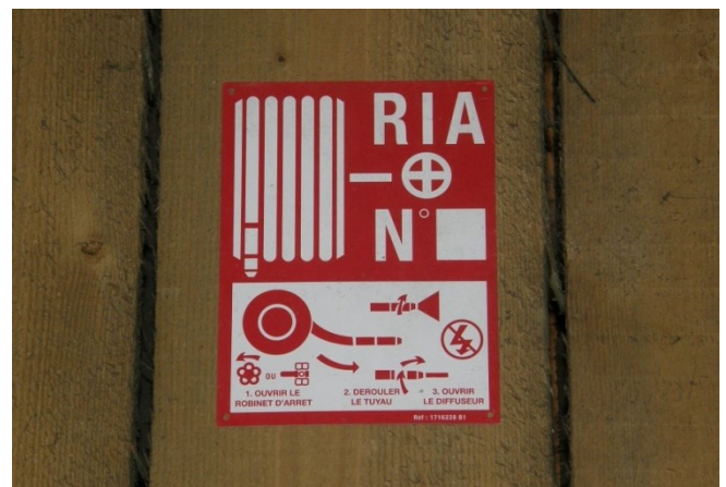
Photo 49 : Panneaux de signalisation RIA
