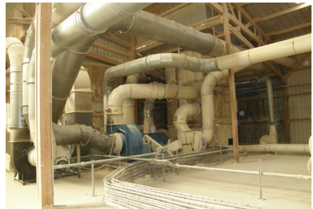
Photo 18 : Aspiration des copeaux
