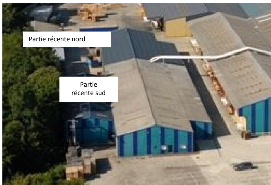
Photo 21 : Bâtiment de stockage (déconstruit)
