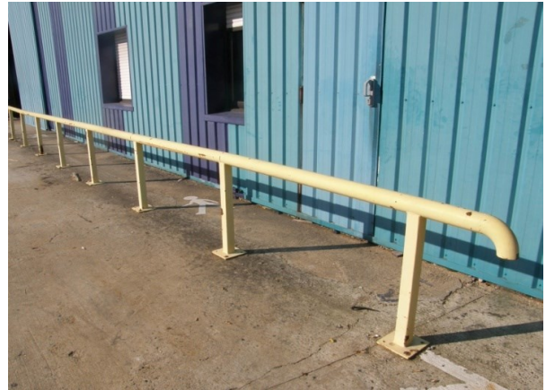
Photo 52 : Barrière de sécurité
