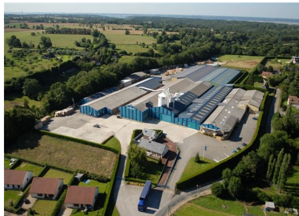
Photo 2 : Vue générale de l'entreprise sur le site de Bouleville depuis le sud-est
