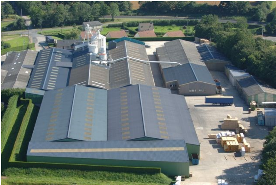
Photo 4 : Vue générale des bâtiments depuis le nord
