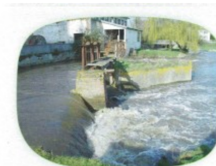
Vue du vannage avant l'aménagement
