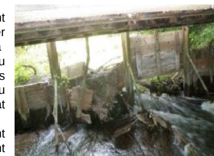
Ouvrage abandonné avec embâcles sur l'Eure (Source SIRE 2)
