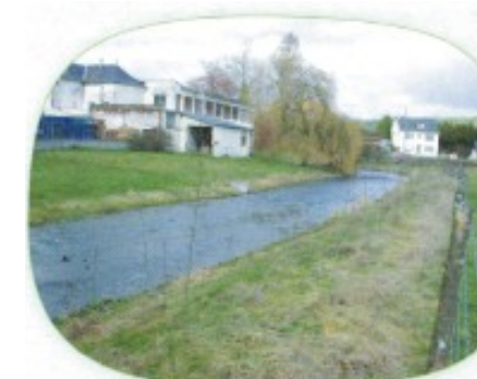
Après suppression du vannage et réaménagement du lit
