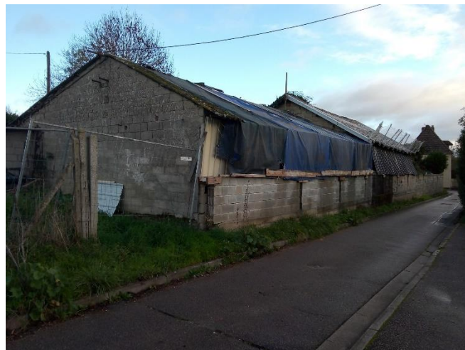
Site vue de l'intersection de la rue Lucas et de la rue de Rouen (photo du 17/11/2022)
