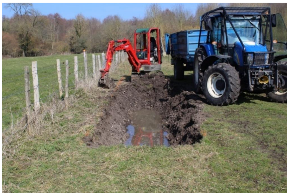
Photo 12 : Création d'un fossé sur la parcelle CASE
