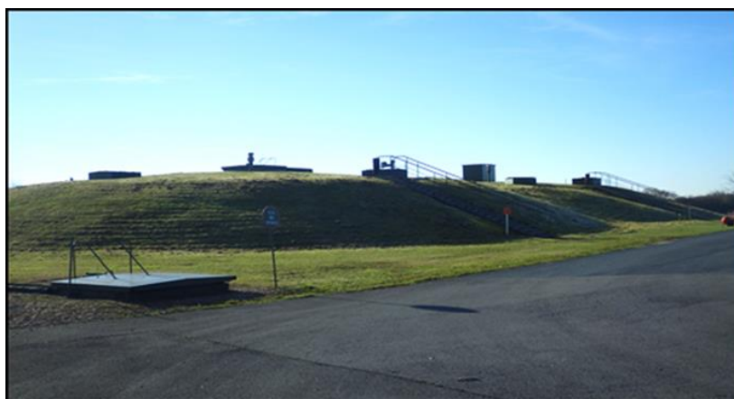
Figure 2 : Exemple de réservoirs enterrés à axe vertical
