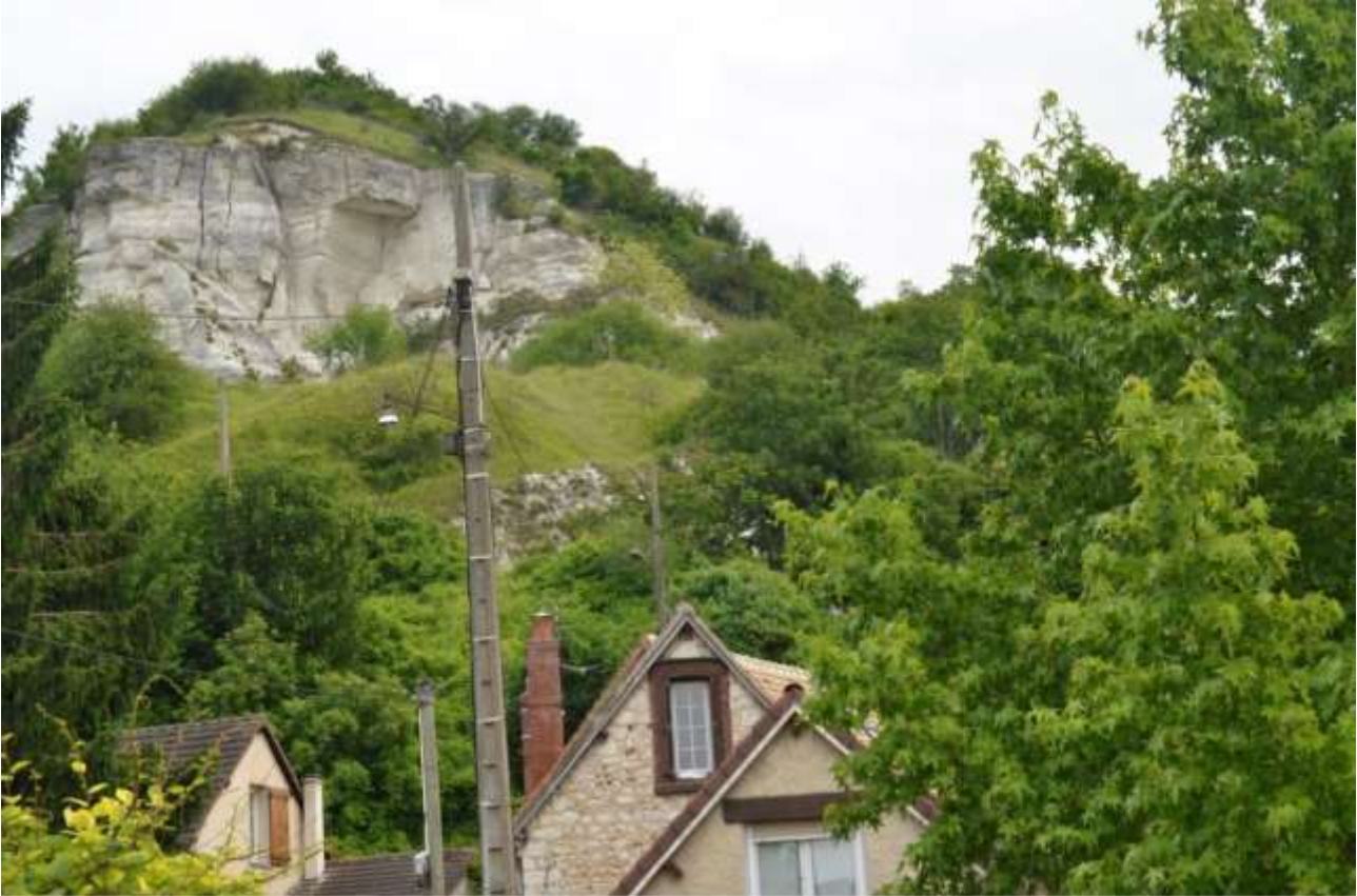
Figure 5 : Exemple d'éléments rocheux à l'arrière d'un quartier résidentiel à Vernon (Source : Etude BRGM 2015)
