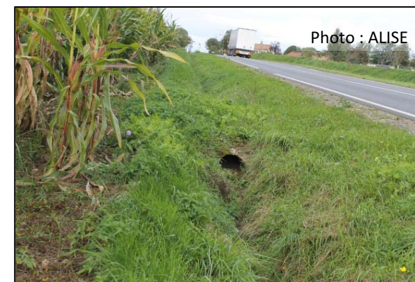
Photo n°3 Fossé situé le long de la RD 6 155
