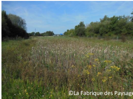
Photo 6 : Bassin de rétention SAPN le long de l'autoroute A13
