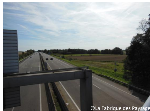
Photo 4 : Vue depuis pont de la Route d'Ingremares
