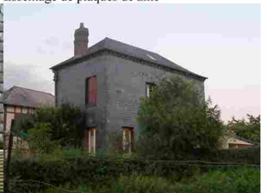
Essentage en ardoise revêtant complètement la construction
