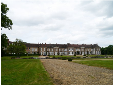
Le corps de logis (vue éloignée)
