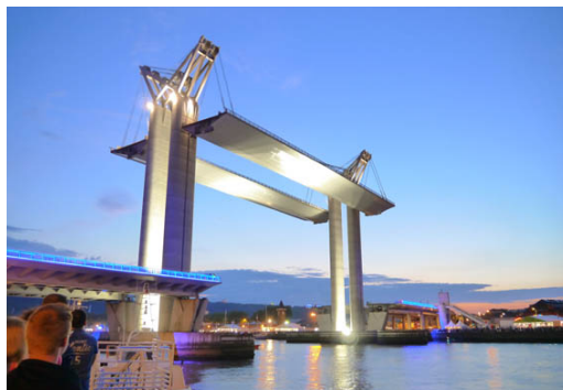
Le 6ème pont de Rouen, dernier pont maritime
