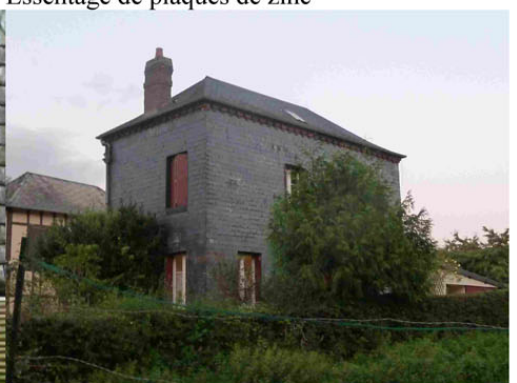
Essentage en ardoise revêtant complètement la construction
