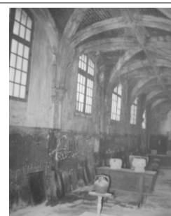
La galerie avant sa réouverture sur le Val.
