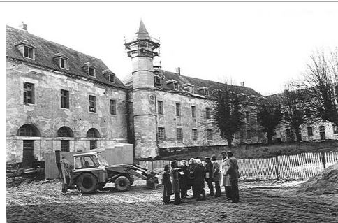
Et assez rapidement, les équipes d'experts se sont succédées sur le site pour déterminer dans quelle direction il fallait orienter les travaux.
