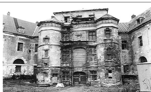
Des travaux d'urgence ont dû être entrepris.
