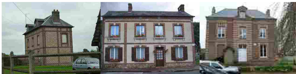
chaînage brique + pierre
