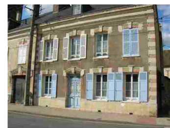
chaînage pierre/brique + enduit
