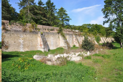
Les soutènements de l'ancien parc
