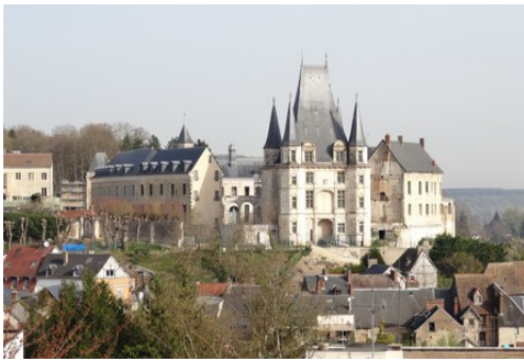
Une vue générale depuis le Sud
