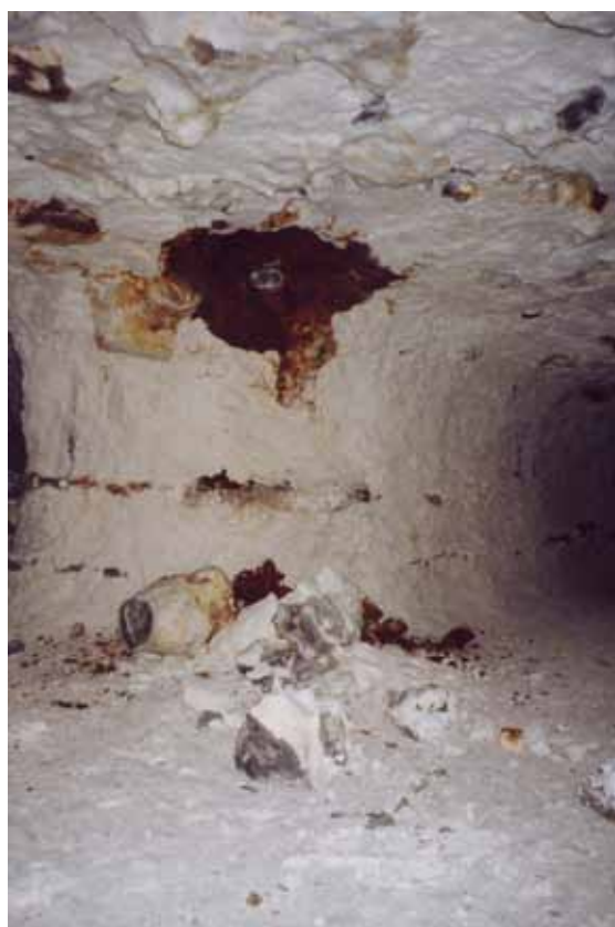
Poche d'argile communiquant avec l'intérieur des galeries (photo DDTM 27)
