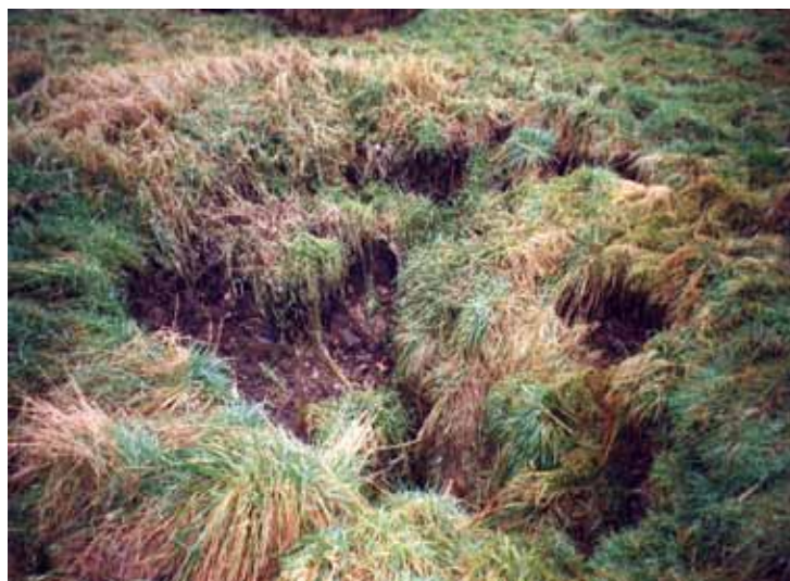
Photographie d'un effondrement de bétoire (photo DDTM27)
