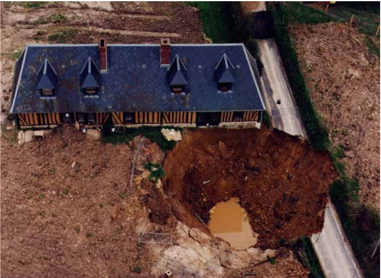
Effondrement de Neuville sur Authou, 2001 (photo SDIS27)
