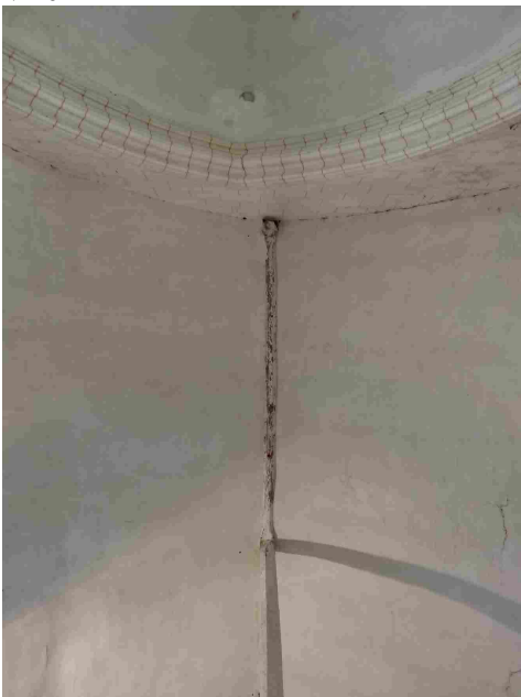
Epreville en Lieuvin (voûte plâtrée)
