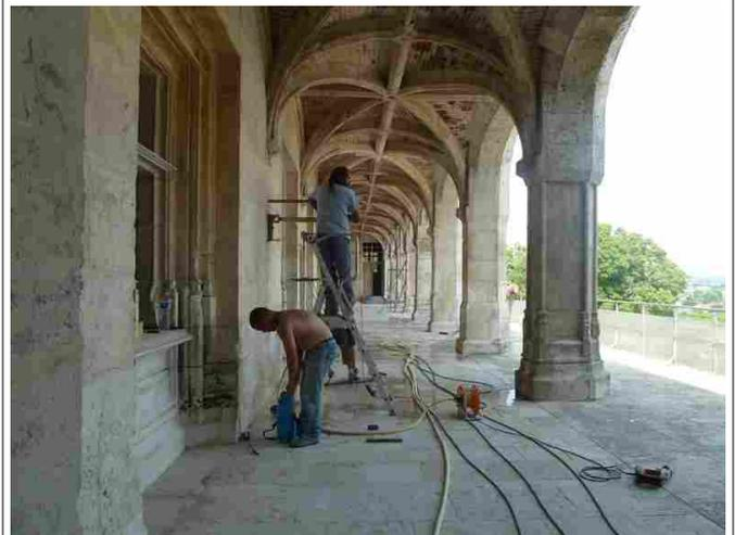
Un percement des murs de plus de 1,5m pour l'installation des luminaires de la galerie.
