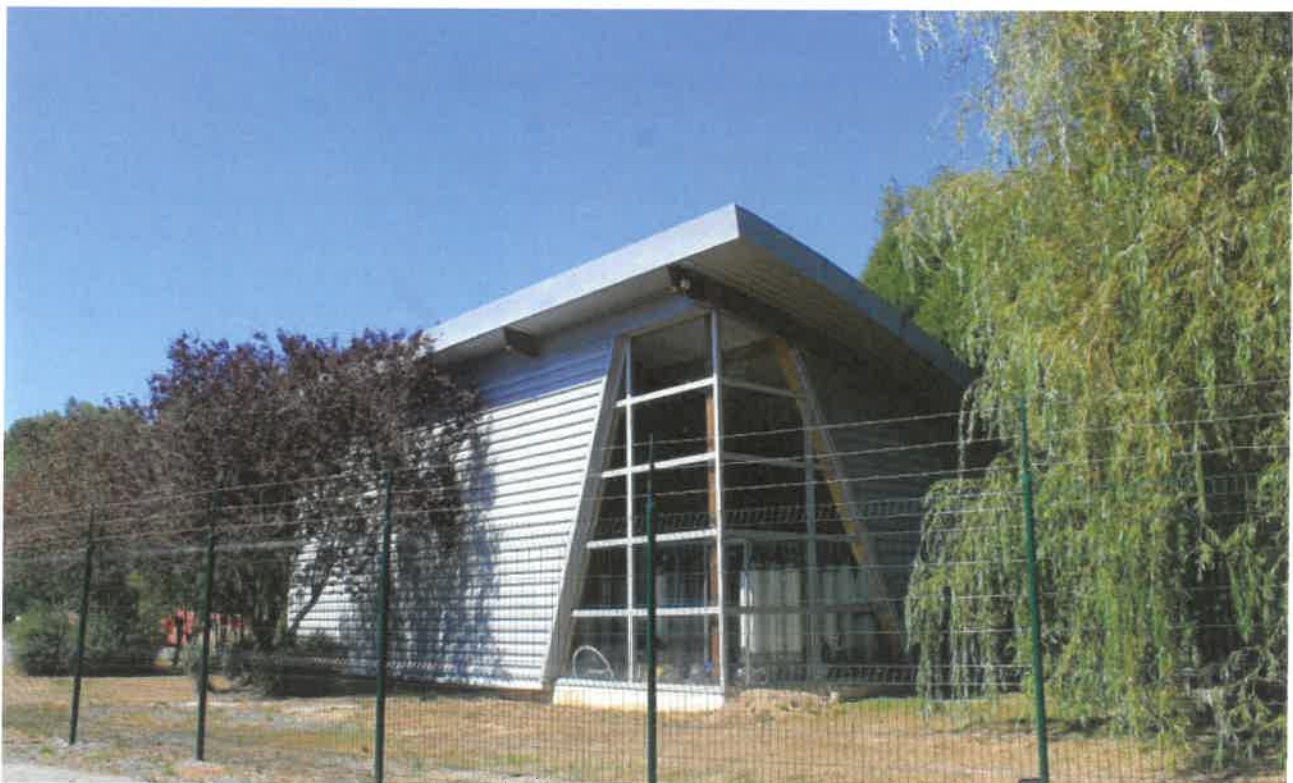
La station d'ultrafiltration du captage des Bruyères
