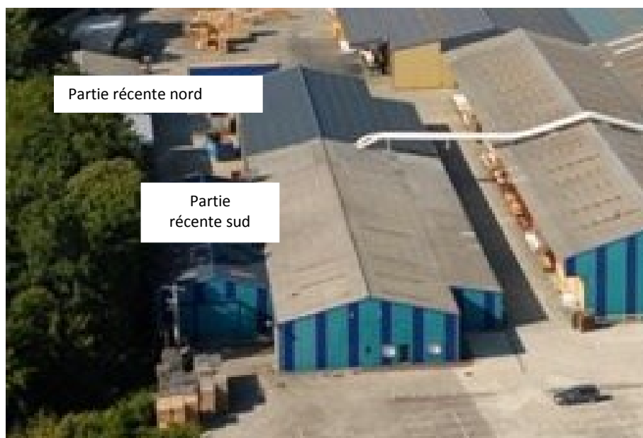
Photo 18 : Bâtiment de stockage (déconstruit)
