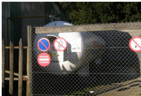
Photo 24 : Citerne de gaz
