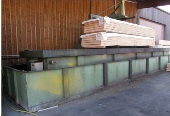
Photo 16 : Traitement par trempage (bac sous auvent extérieur)
