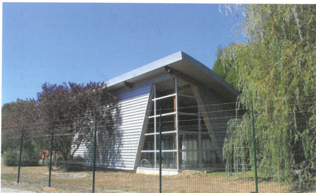
La station d'ultrafiltration du captage des Bruyères
