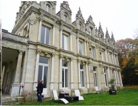
La façade sud vers la Seine
