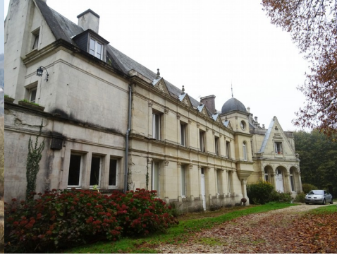
La façade nord
