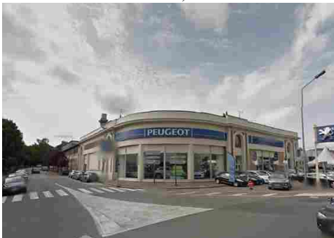
LOUVIERS, Garage automobile, 1932 (archi : RAVAZE Maurice-Jacques)
